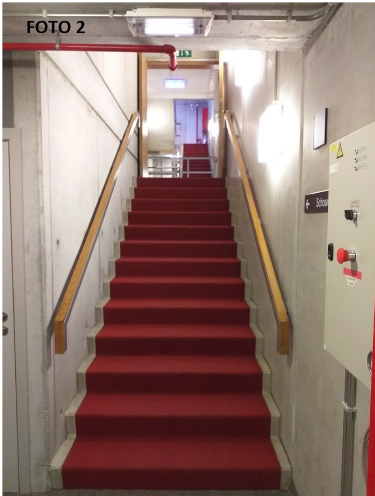
Foto 2: traphal, hoogte 2,25m, breedte 1,2m.
